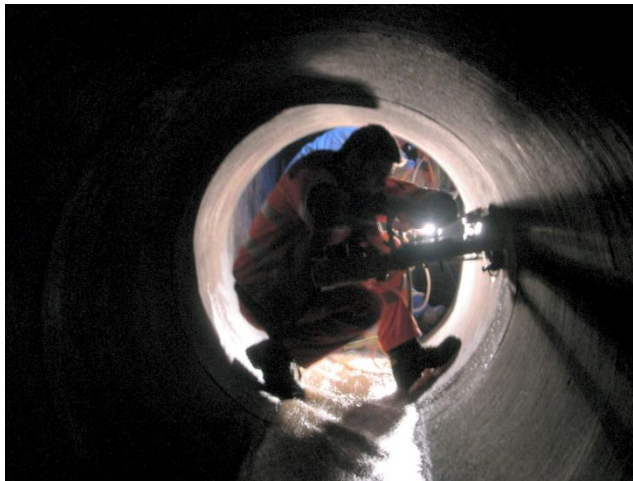
Entnahme von Bohrkern in Kanal
