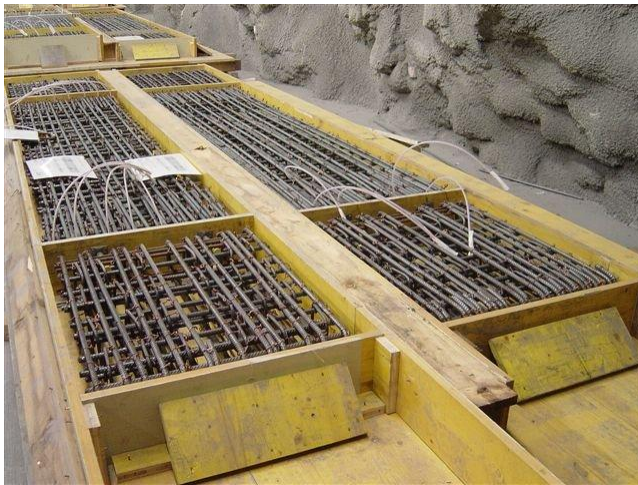
Elementherstellung (Querkraftelement, Schubdorne)
