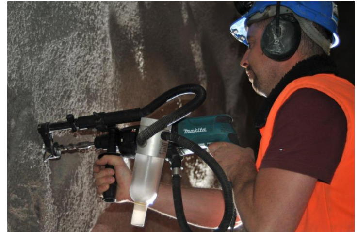
Entnahme von Bohrmehl
