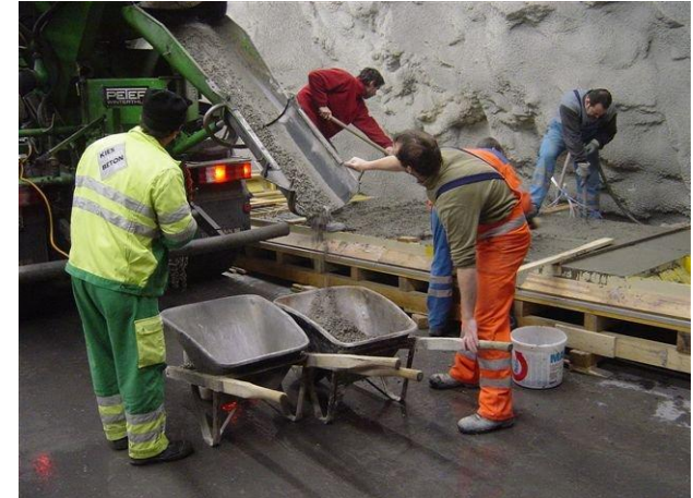
Betonierarbeiten mit Qualitätskontrollen Frischbeton
