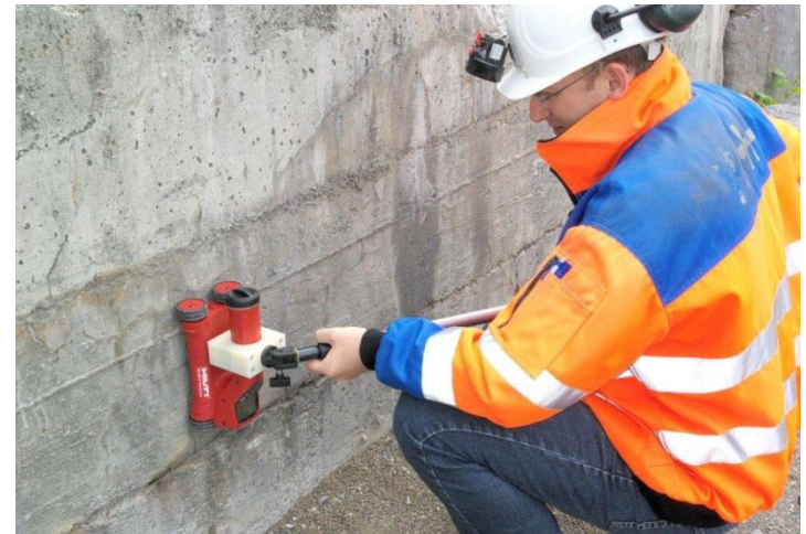
Messung der Bewehrungsüberdeckung
