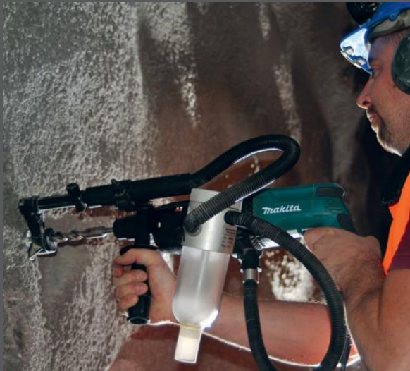
Bohrmehlentnahme am Objekt
