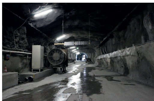
5 | Versuchsplatz Stollen «B» (links) und darauffolgende Messstrecke (rechts). 5 | Site d'essai de la galerie «B» (à gauche) et section de mesure adjacente (à droite).
