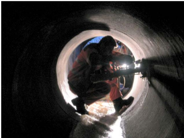
Entnahme von Bohrkern in Kanal
