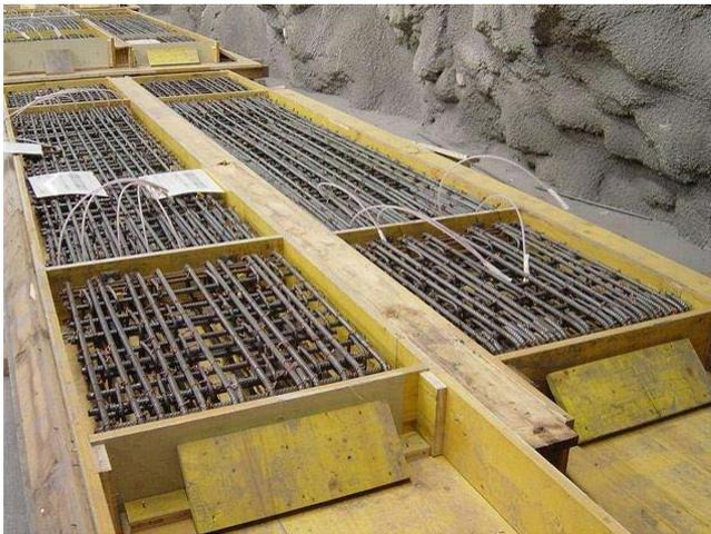
Elementherstellung (Querkraftelement, Schubdorne)
