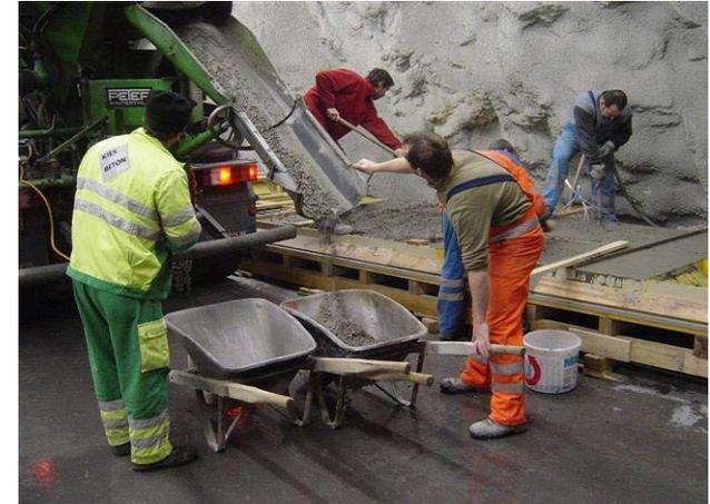
Betonarbeiten mit Qualitätskontrollen Frischbeton
