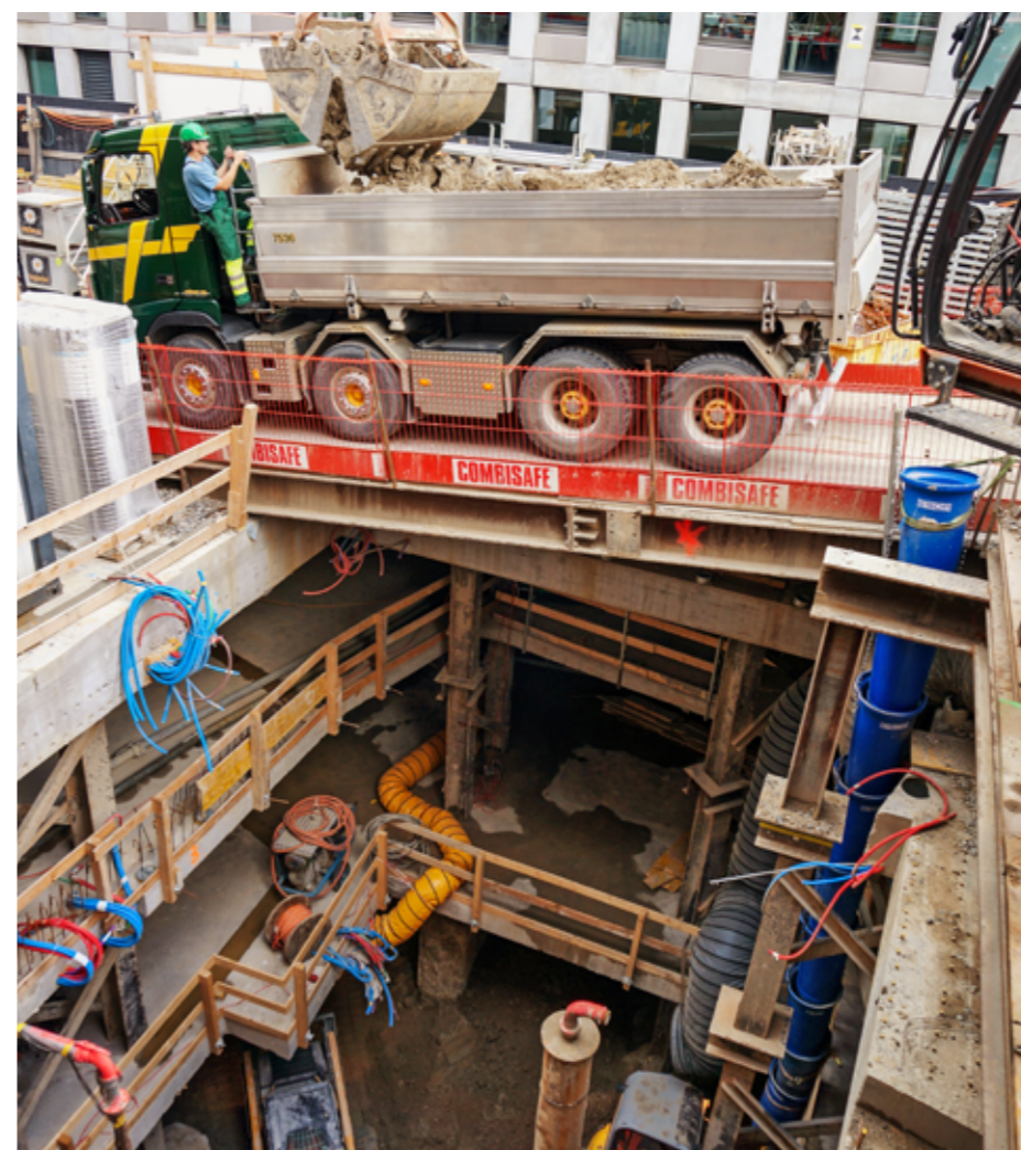
Komplizierte Bauverhältnisse erfordern spezielle Techniken: Beim Bau des Andresturms kam beim Aushub der Teledipper Hitachi ZX350LC-3 zum Einsatz.
