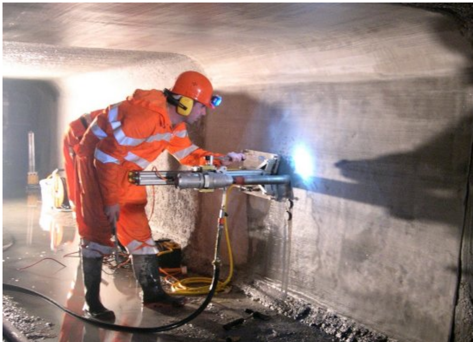
Bohrkernentnahme in begehrbarer Kanalisation
