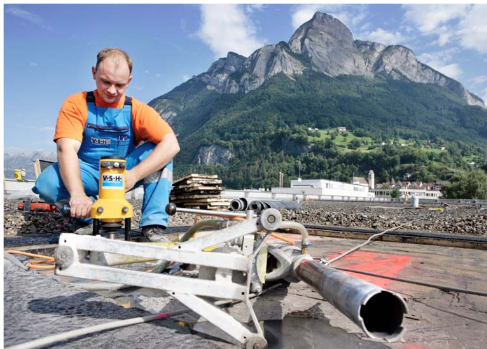
Qualitätskontrolle vor Ort (Haftzugfestigkeit am Objekt)
