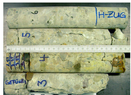
Bohrkerne für weitere Prüfungen im Labor
