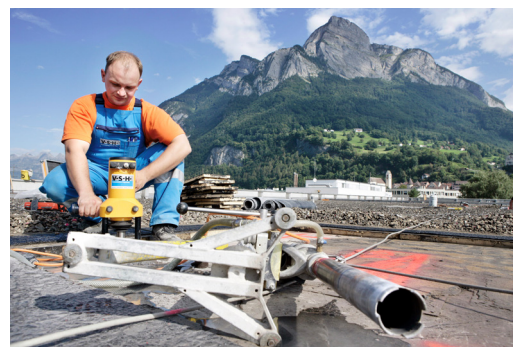
Prüfung der Haftzugfestigkeit und Bohrkernentnahme am Objekt
